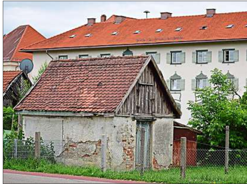
Auch die kleineren Hütten am Rand der Gärten sind sanierungsbedürftig: An vielen Stellen ist der Putz abgeblättert und das Holz ist morsch.
